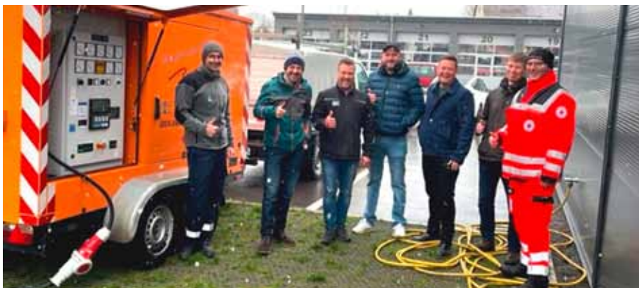
Funktionierende Notstromversorgung durch das Überlandwerk während des simulierten Stromausfalls. Alle Akteure zeigten sich zufrieden: v. l. Simon Hergenhan, Dieter Esau, Michael Haaf, Ulrich Schmitt, Stefan Federlein, Dominik Heitel, Mario Hahn. Foto: Ralf Baumeister BRK
